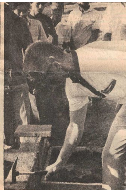
El Embajador de la RDA en Nicaragua, Henry Märtz, coloca la primera piedra de la segunda etapa del hospital Carlos Marx.
